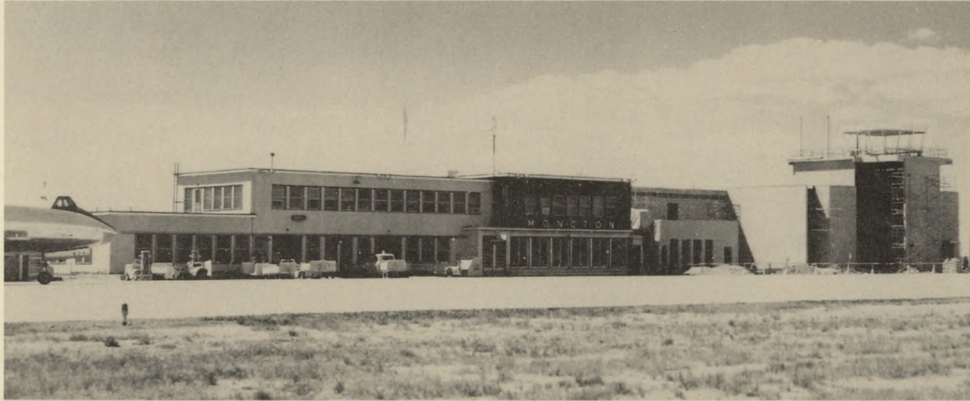
AÉROPORT DE MONCTON - 1965-1966 Agrandissement et construction de la tour de contrôle
