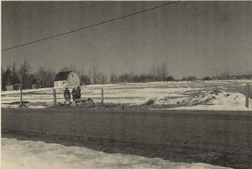
PREMIÈRE PELLETÉE DE TERRE Début de la construction de l'Aréna Saint-Anselme
