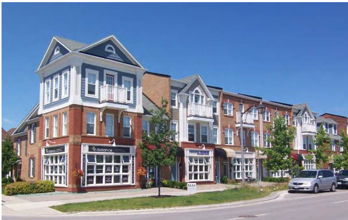
Figure 5.21: Exemple d'un bâtiment mixte à Cornell, Markham, ON
