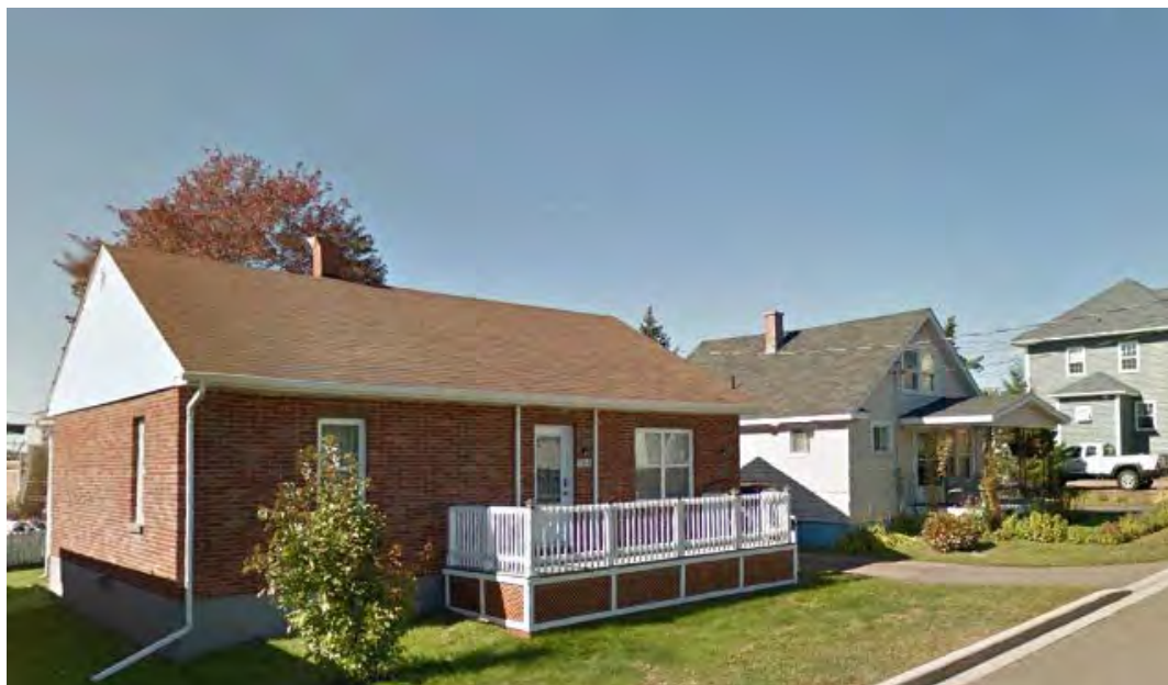
Figure 4.12: Bâtiment résidentiel de faible densité situé à l'intérieur du secteur à l'étude
